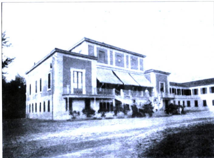
Albergo Ristorante delle Terme di Castel San Pietro Terme (Bologna) - Anni '30
